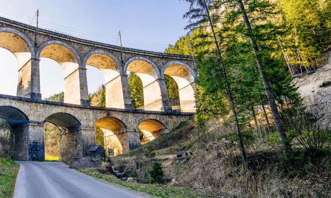
Viadukt „Kalte Rinne“, Viaduct „Kalte Rinne“
